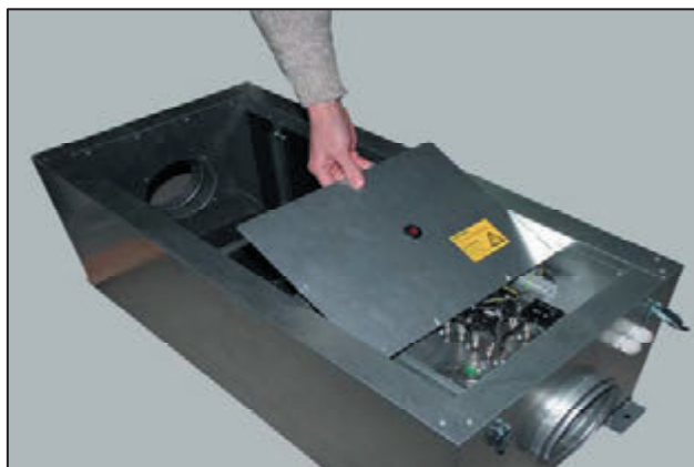
6. Установите защитную панель отсека нагревателя
