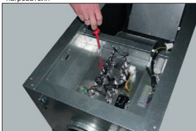
4. Зафиксируйте нагреватель с помощью саморезов
