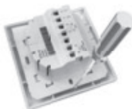
Рисунок 5. Демонтаж лицевой панели
